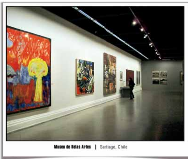
Foto 6 – sistema localizado com lâmpadas fluorescentes tubulares – efeito wall washer, com sombra indesejável na parte superior da parede.
